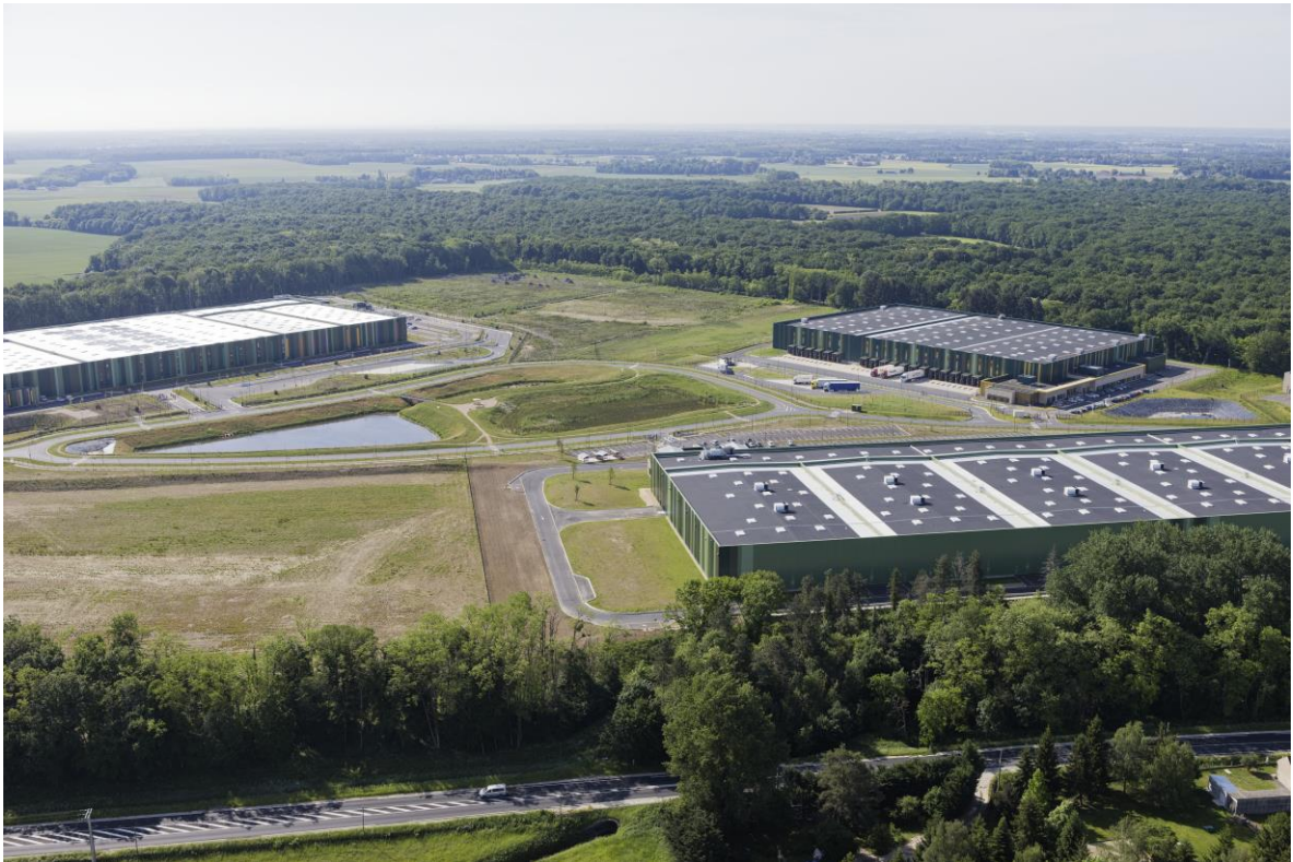
PC8-1: Vue lointaine et aérienne depuis la limite ouest du Cosméticpark
