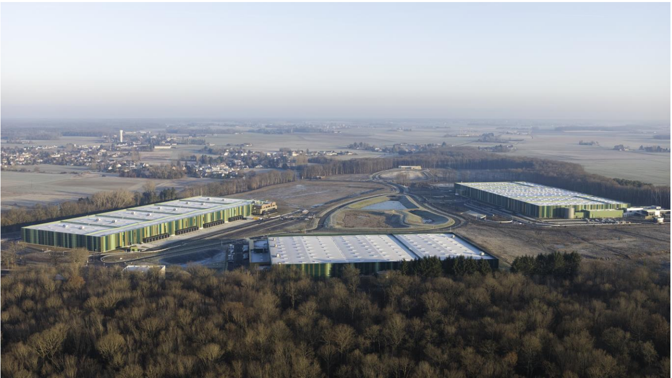
PC7-2 : Vue proche et aérienne depuis façade sud du site, au premier plan la façade arrière du bâtiment DIOR 1 existant.
